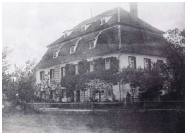
38 Im Garten des Pfarrhauses wurde für Maria Elisabeth Stapp ein kleiner Atelierbau errichtet
